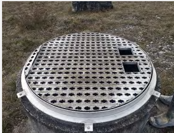
Grille du conduit d'aération à l'extérieur du site
