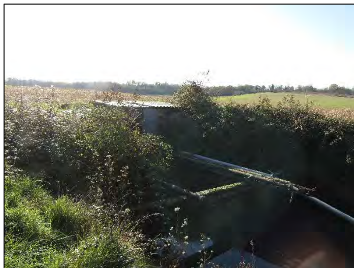
Vue sur la station de pompage
