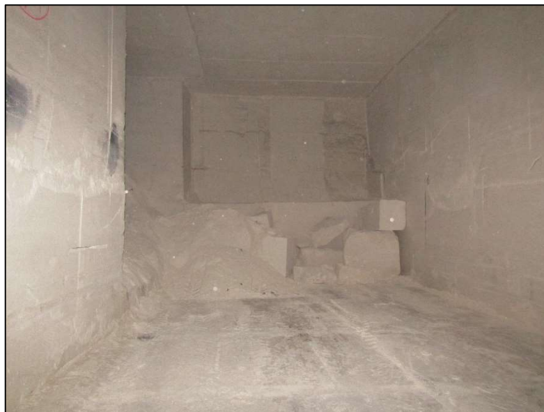
Exemple d'amorce de remblayage
