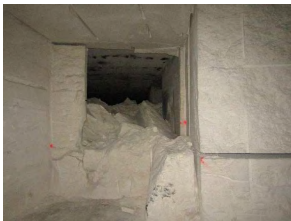
Galerie dans la zone non exploitée
